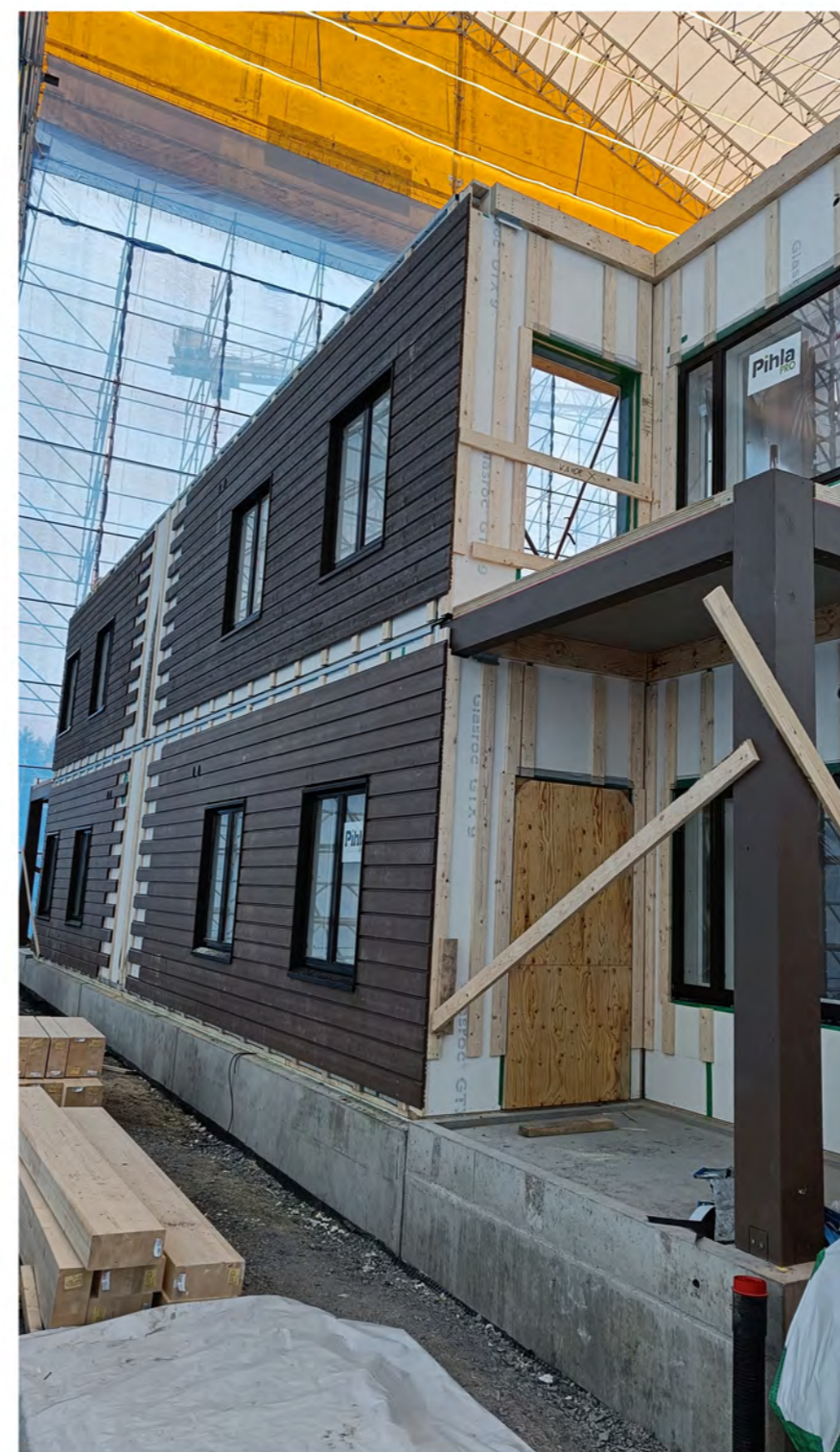
Kuloistenniityn Apila rakennetaan puuelementeistä turvallisesti sääsuojan alla.
