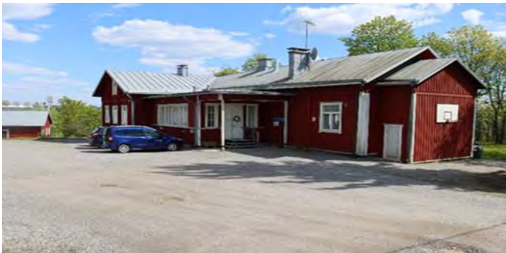
Mahittulan toimintakeskuksen päärakennus
