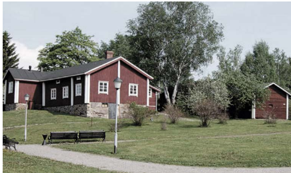
Perinteinen rakentaminen luonnon ehdoilla
